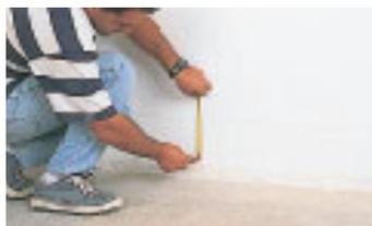
**2. Tracer la canalisation d'évacuation avec une pente de 2 à 3 cm par mètre.**
